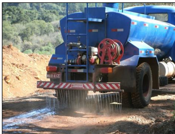
Figura 7 – Umidificação de acesso para a redução do nível de poeira.
