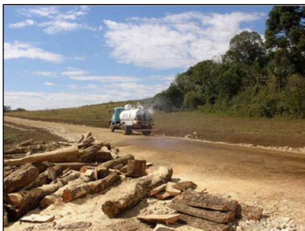
Figura 6 – Umidificação de acesso para a redução do nível de poeira.
